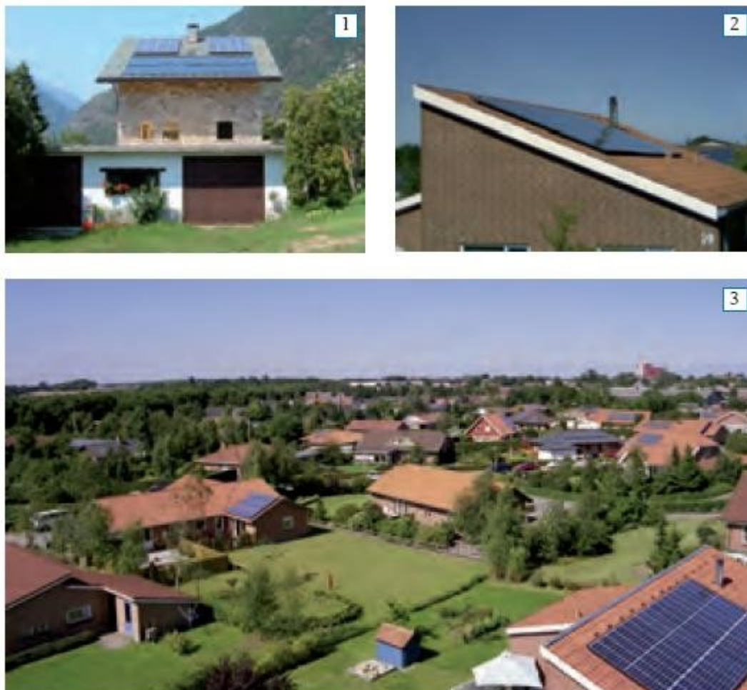
Fig 1 - Edificio adibito ad uso abitativo, Italia Fig 2, 3 - Sol 300, Danimarca
