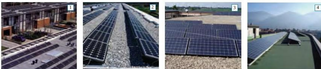
Fig.1, 2 - Villaggio solare a Amersfoort, Olanda Fig.3 - Installazione su tetto piano, Italia, Fonte GSE Fig.4 - Installazione su tetto piano, Italia, Fonte GSE
